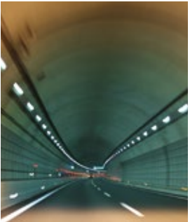
トンネル非常用設備
